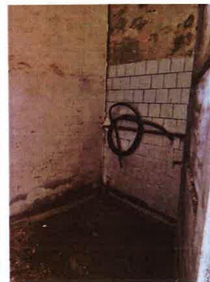
Viena no kompresoru ēkas telpām
